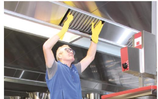
Bild 6: Reinigungsarbeiten mit entsprechender Schutzausrüstung vornehmen
