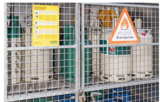
Bild 8: Korrekt gelagerte Gasflaschen
