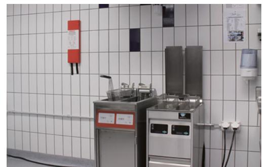
Bild 5: Löschdecke griffbereit neben der Fritteuse bereitstellen
