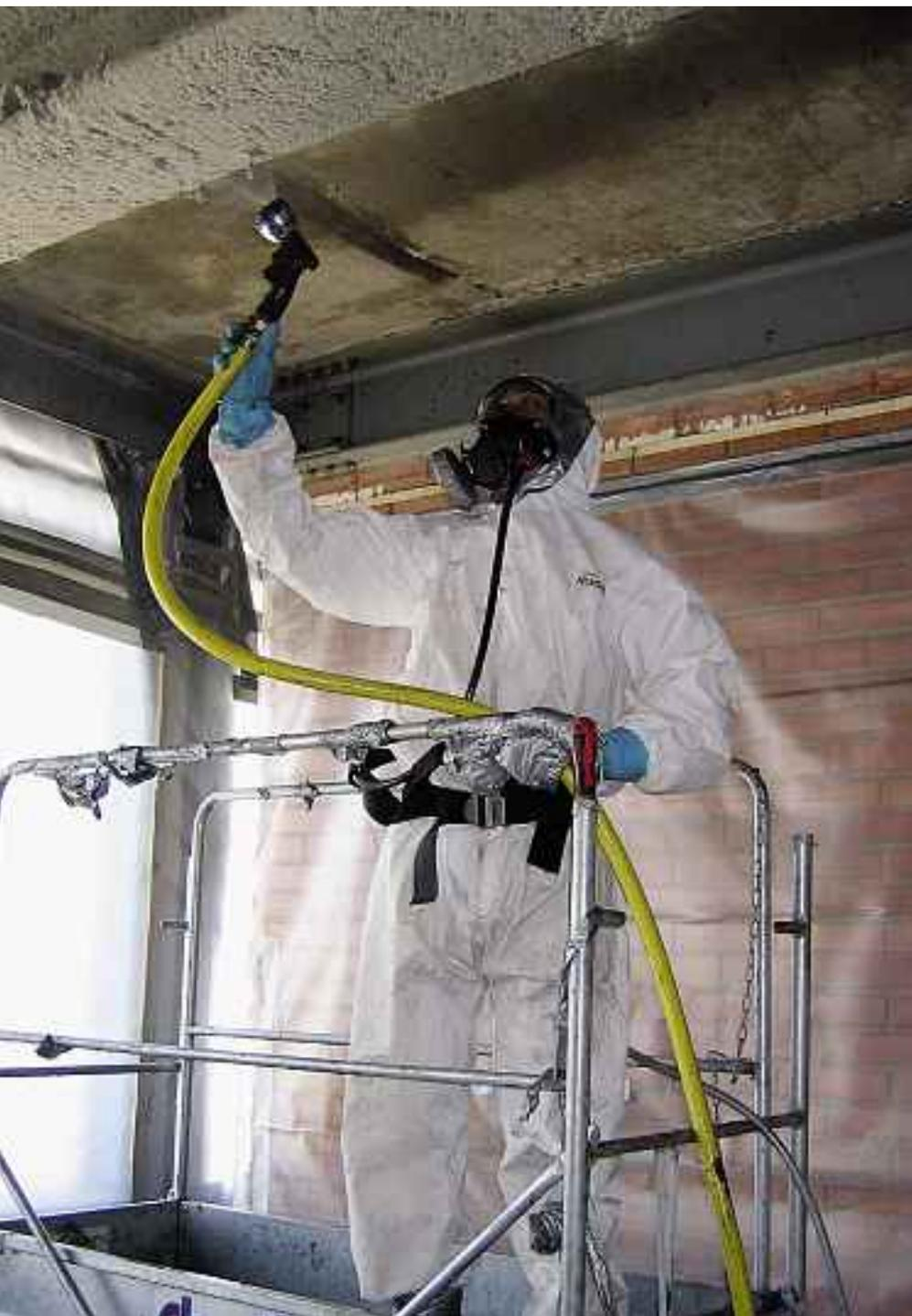
*Asbestsanierer mit Frischluftgerät, Sanierung im Nassverfahren.*
