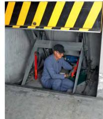
Arbeitnehmer: Ich sage STOPP, wenn ich gefährliche Energien erkenne (z. B. ungesicherte, angehobene Last). An laufenden Anlagen arbeite ich nur, wenn geeignete Sonderbetriebseinrichtungen für meine Sicherheit vorhanden sind (z. B. Zustimmtaste). Vorgesetzter: Ich lege fest, wie gefährliche Energien zu sichern sind. Arbeiten an laufenden Anlagen lasse ich nur zu, wenn die erforderlichen Sonderbetriebseinrichtungen vorhanden sind.
