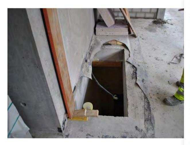
Wir sichern Bodenöffnungen unverrückbar und durchbruchsicher.
