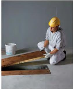
Arbeitnehmer: Treffe ich ungesicherte Bodenöffnungen an, sichere ich sie unverzüglich. Vorgesetzter: Ich kontrolliere die Baustelle regelmässig und lasse Bodenöffnungen sofort sichern.
