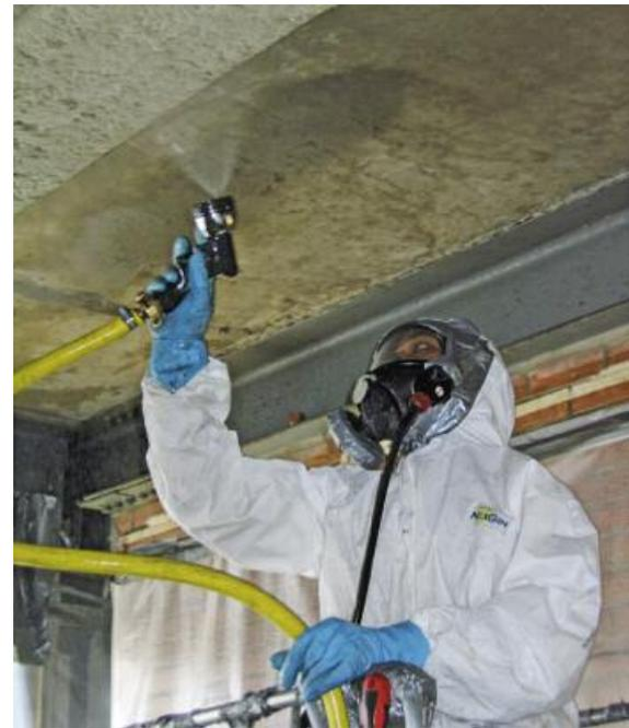
Fig. 4: enlèvement d'amiante floqué sur un chantier d'assainissement.
