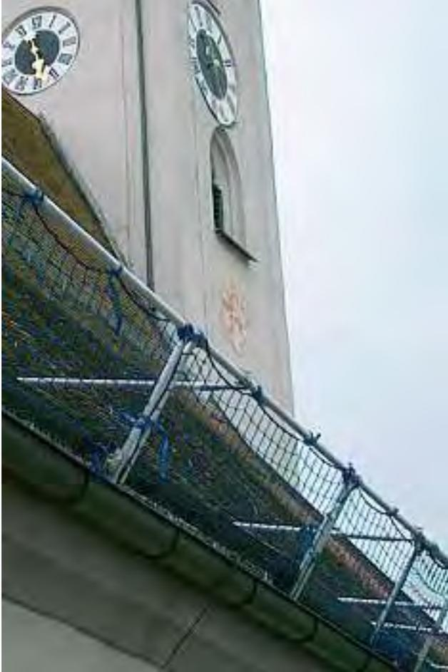
Neu können Arbeiten auf Dächern mit einer Dachneigung bis 40° im Schutz einer 100 cm hohen Dachfangwand ausgeführt werden.
